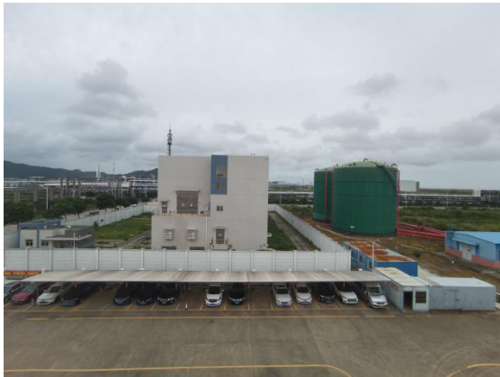
东北角 110KV 开关站 (1)
