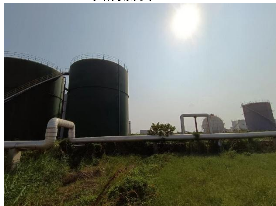
西南侧金鸡化工 (5)
